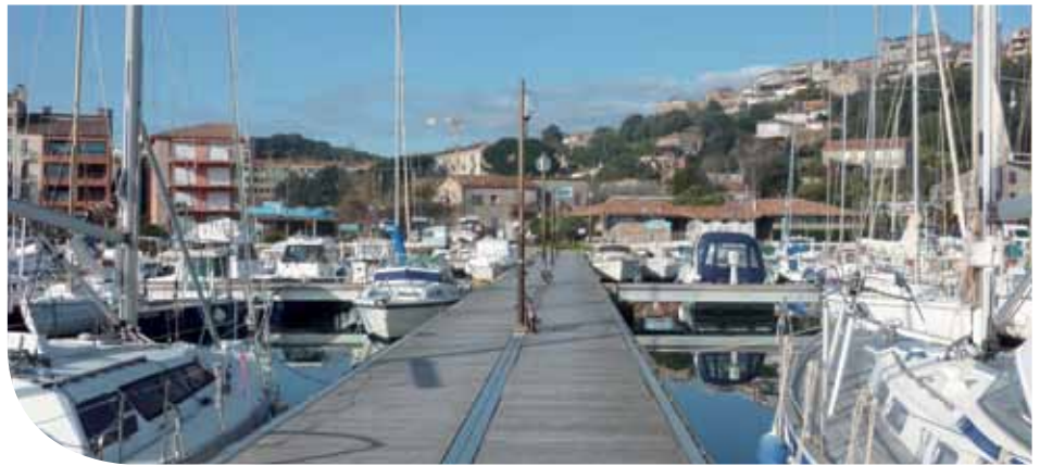
Pour supprimer l'impact sur le lit de mer de certains dispositifs, le projet prévoit des petits appontements flottants.
