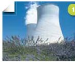
Centrale de Cruas
