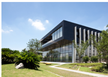
Data center du Campus numérique de la Bourse de Shanghai
