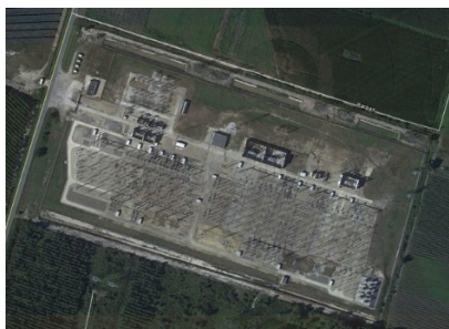
Vue aérienne du poste de Saucats
