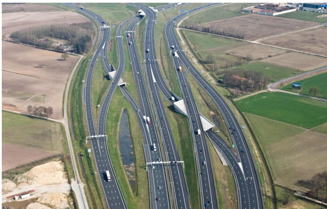
Figure 6 : L'échangeur A2/A58 au droit d'Eindhoven avec les accès aux doubles autoroutes de transit et de desserte d'agglomération
