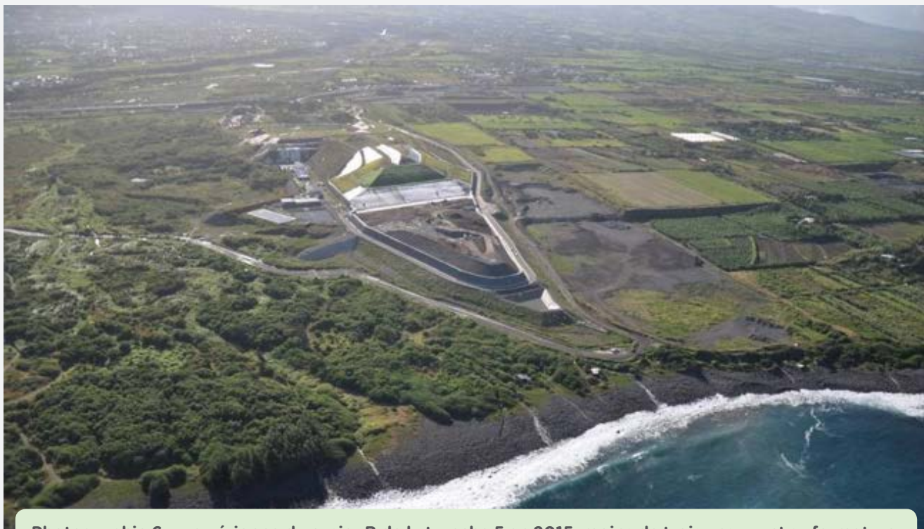
Photographie 6: vue aérienne du casier B de la tranche 5 en 2015, moins de trois ans avant sa fermeture.
