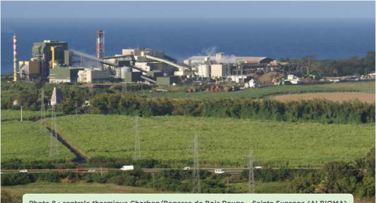
Photo 8 : centrale thermique Charbon/Bagasse de Bois Rouge - Sainte Suzanne (ALBIOMA)
