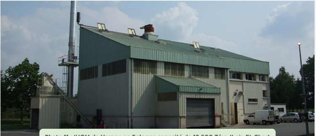
Photo 11 : IUOM de Vernou en Sologne capacité de 12 500 T/an (Loir-Et-Cher)
