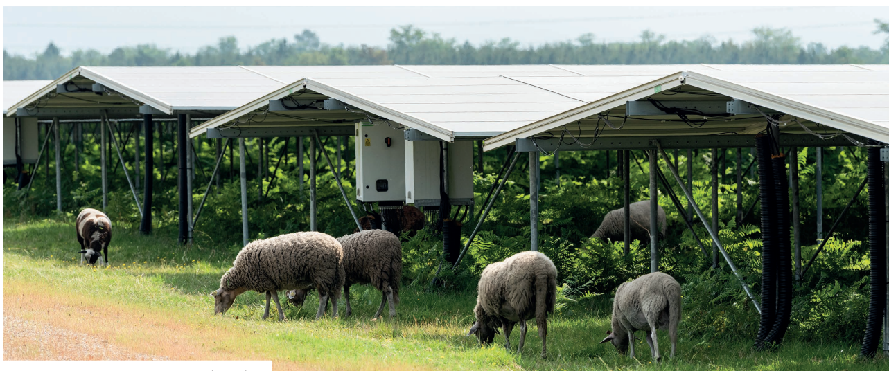
Parc photovoltaïque de Cestas (2021)
