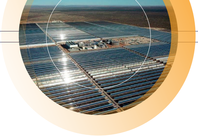
Centrale solaire à concentration sud-africaine Kathu Solar
