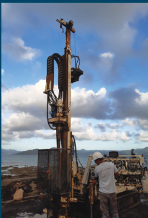
Sondages géotechniques sur le site de l'aéroport.
