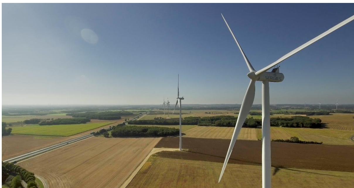
Parc éolien de Chaunay (86)
