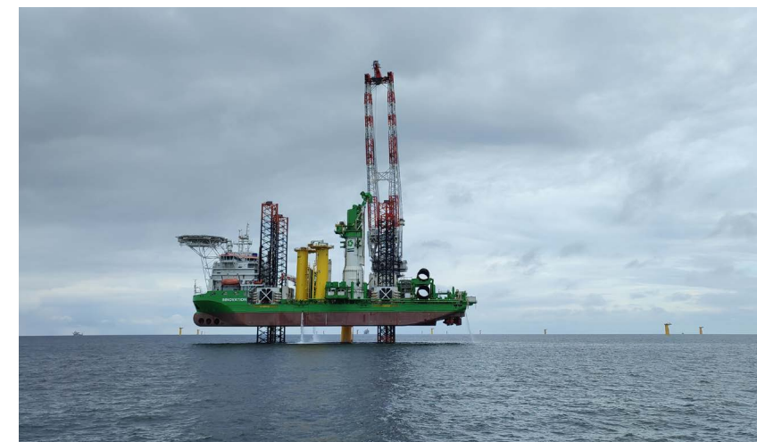
La navire Innovation installant les pieux des éoliennes du parc de St Nazaire
