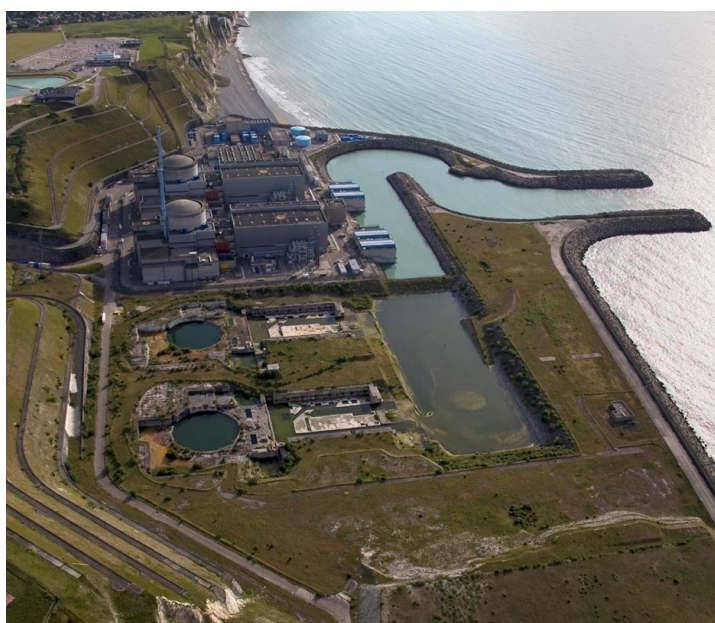
Figure 3. Site nucléaire existant de Penly
