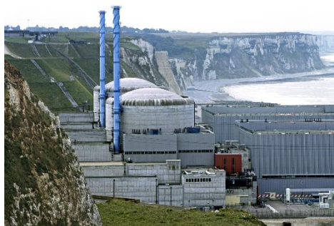
Figure 1 : Centrale nucléaire de production d'électricité de Penly
