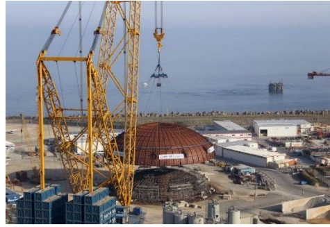
Figure 1 : Chantier Flamanville – L'alsace.fr
