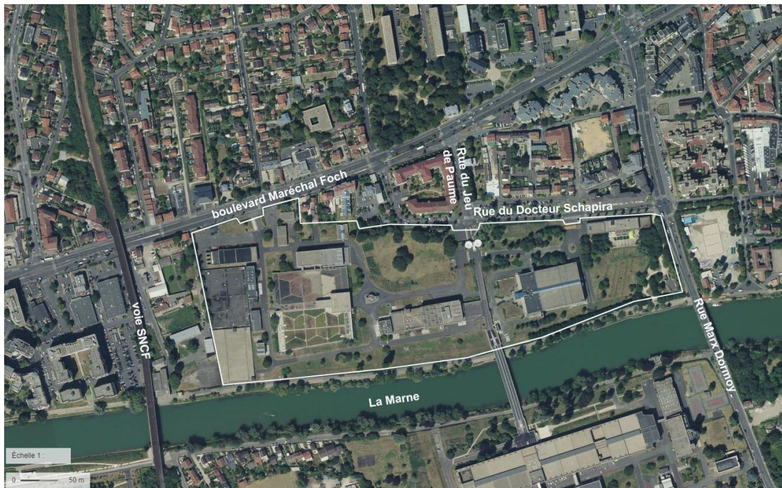
Figure 2 : Vue aérienne du site de l'usine dans la trame urbaine (source © Geoportail 2019)
