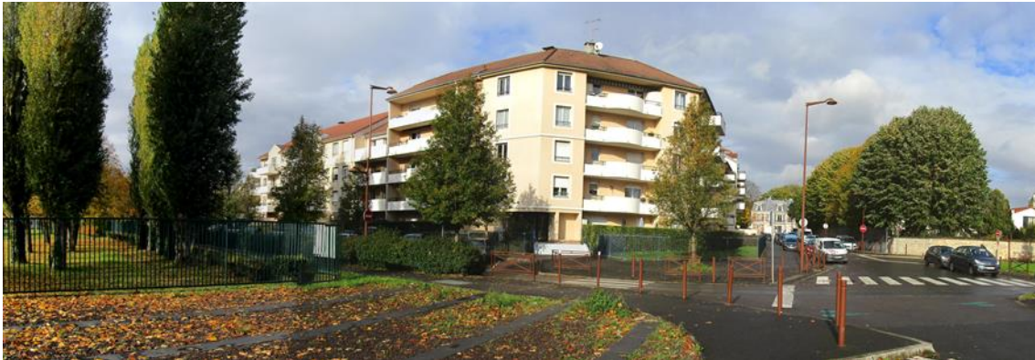
Figure 9 : Vue des immeubles situés face à l'entrée de l'usine côté Neuilly (Photos © Ateliers UP+SCE 2019)
