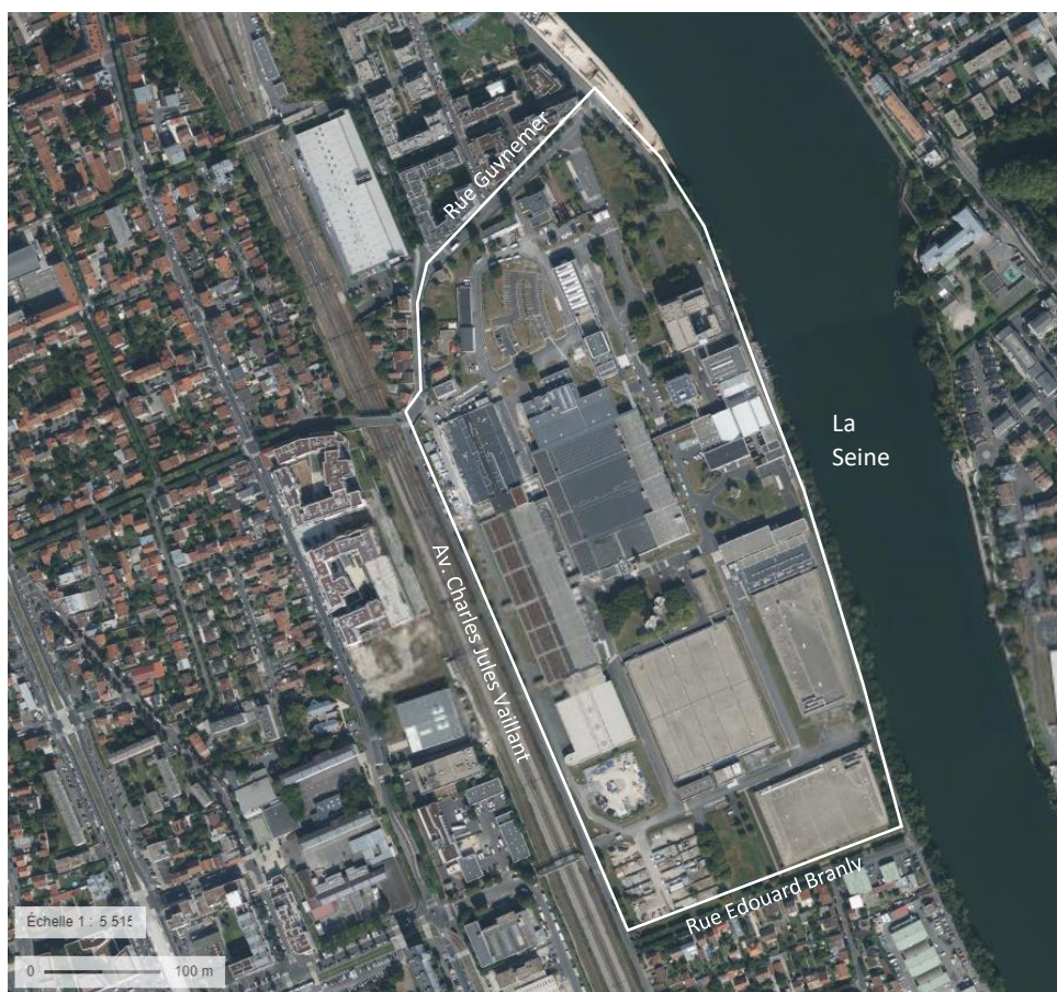
Figure 1 : Vue aérienne du site de l'usine dans la trame urbaine (source © Geoportail 2021)
