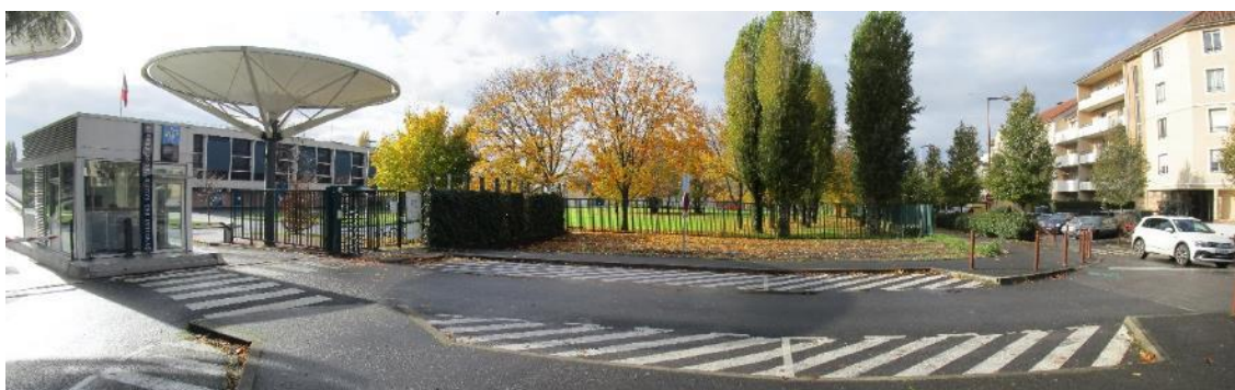
Figure 20 : Vue des arbres depuis l'accès principal, en avant du projet de bâtiment (Photos © Ateliers UP+SCE 2019)
