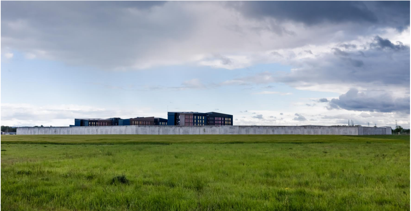
Centre pénitentiaire de Lutterbach
