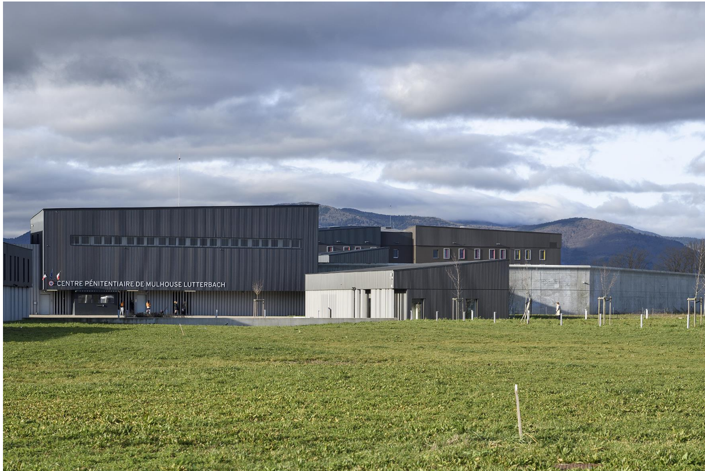
Centre pénitentiaire de Lutterbach
