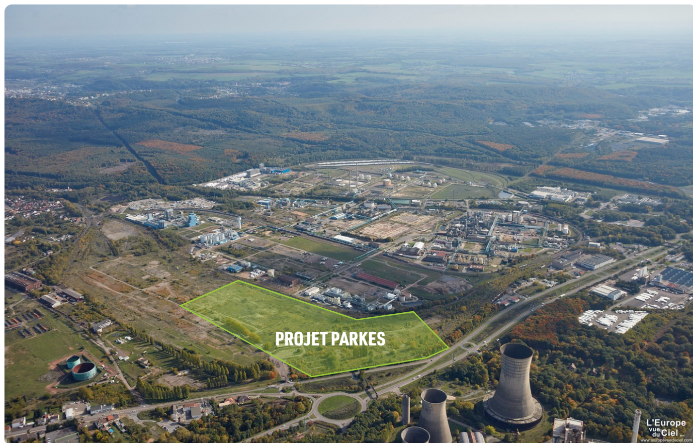
Figure 8 : Vue aérienne du site d'implantation (au premier plan à gauche), au sein de la plateforme Chemesis.
