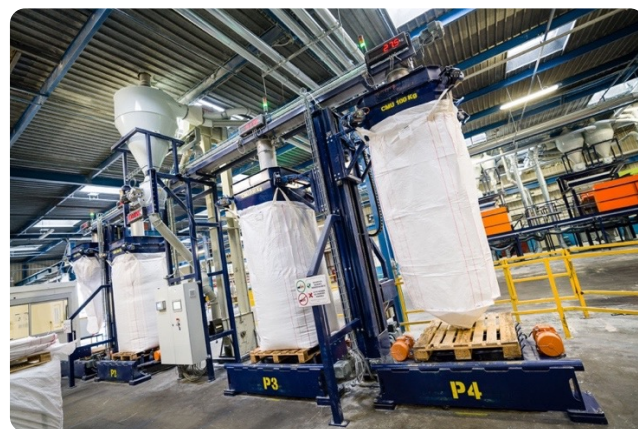
Figure 13 : Conditionnement de déchets en «big-bag»
