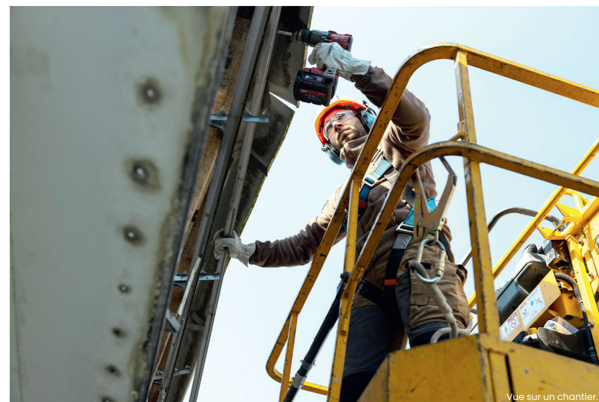
Vue sur un chantier.
