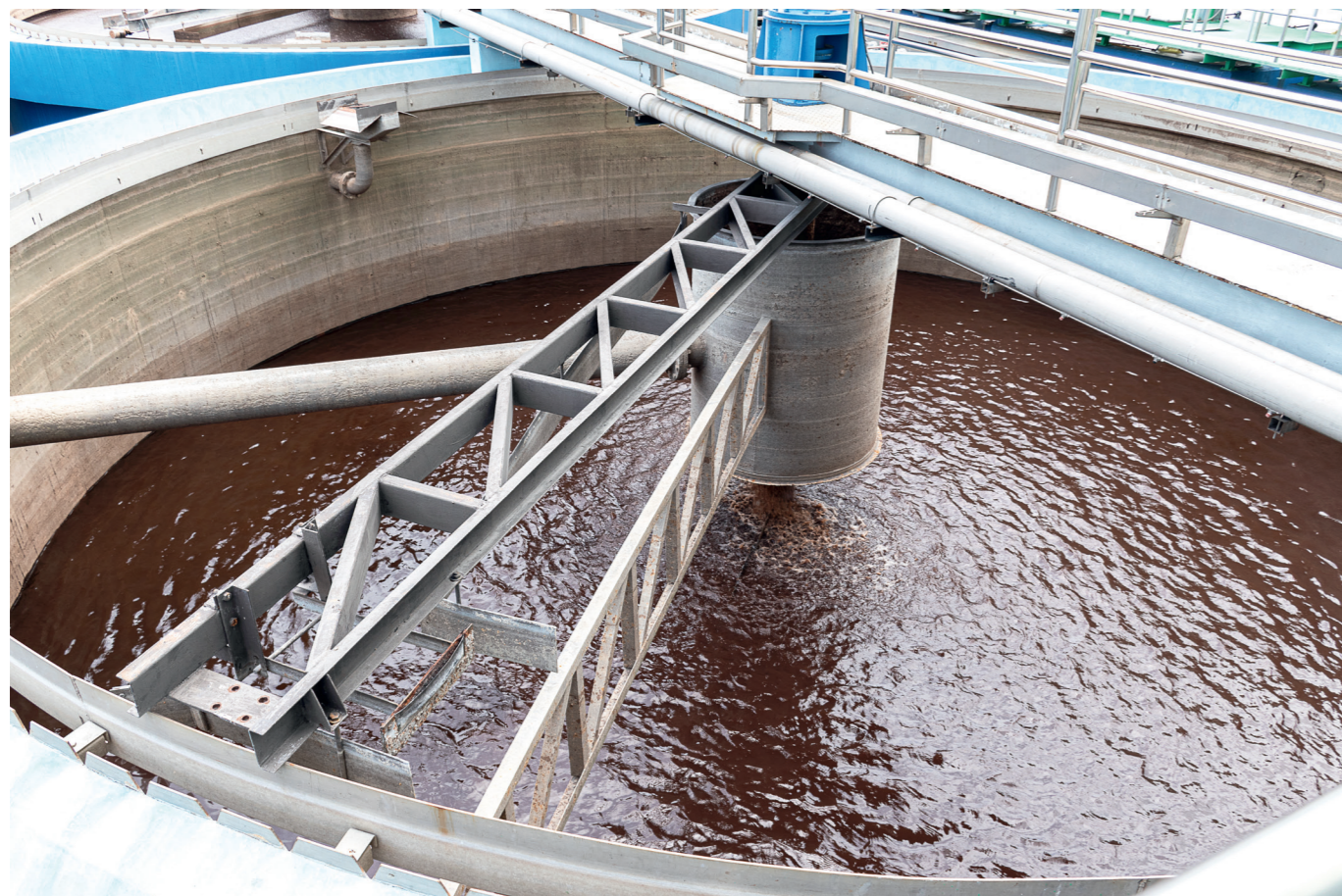
Vue d'une station d'épuration*
