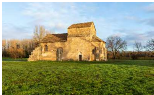
France, Ain (01), Saint Vulbas, chapelle de Marcilleux, classée Monument Historique, propriété privée (XI e siècle)
