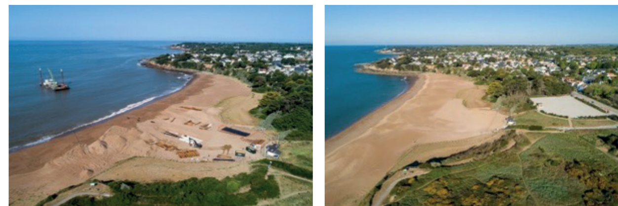
Plage de la Courance, Saint-Nazaire : Pendant et après travaux en tranchée
