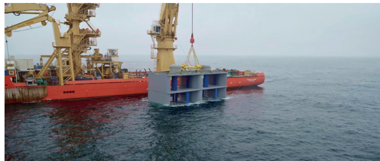
Mise à l'eau de l'hydrolienne d'Hydroquest à Paimpol-Bréhat en 2019 (démonstrateur de 1 MW)
