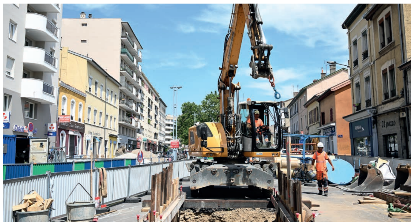
►► Dévoisement de réseau, rue Verlaine à Villeurbanne.
