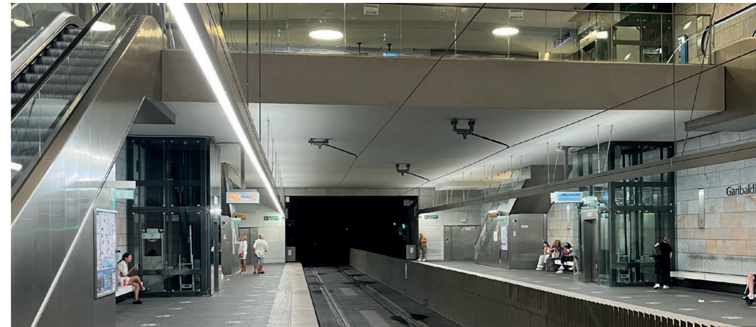
Station Garibaldi souterraine de la ligne 2 du tramway de Nice.
