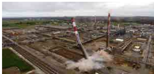
Destruction des dernières cheminées des usines à soufre Total le 31 mars 2018, à l'arrêt depuis 2013. Photo par France Bleu Béarn.
