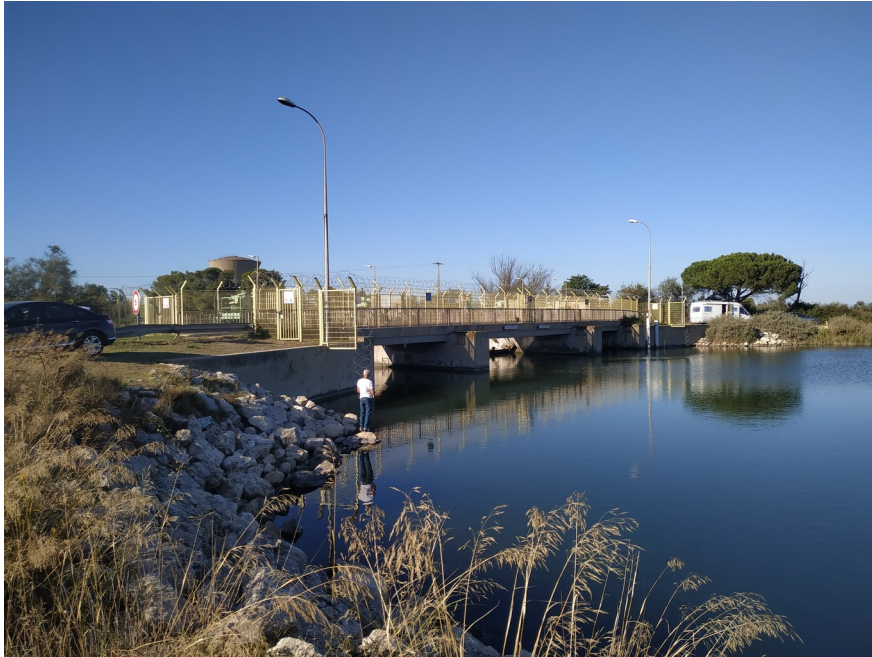
Le barrage antisel (photo garants)
