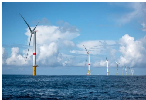
Figure 2 : photographie du parc éolien de Saint-Nazaire (Infographie : © Parc éolien en mer de Saint-Nazaire - Production CAPA Corporate)
