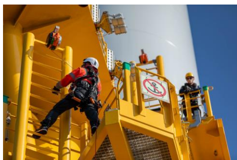
Opération de maintenance sur le parc éolien de Saint-Brieuc. Crédit photo : C. Bessier
