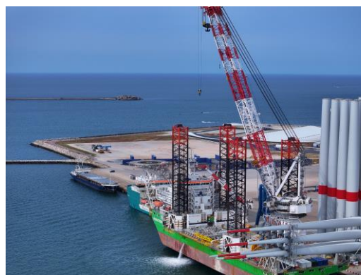
Chargement d'un navire d'installation - Port de Cherbourg ©Biplan-L.Pouyadoux
