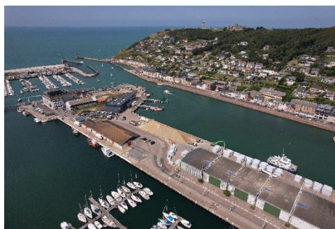
Vue aérienne du Port de Fécamp
