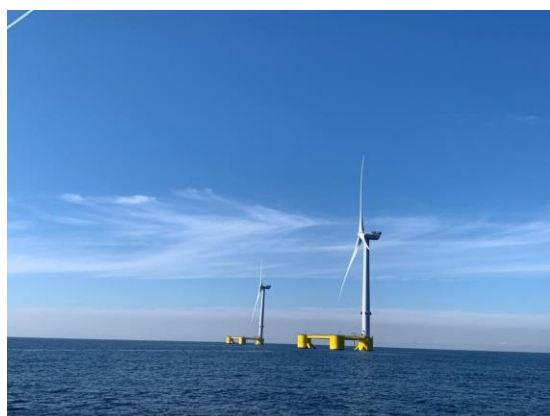
Figure 3 – Parc éolien flottant WindFloat Atlantic. Portugal Crédits : OW
