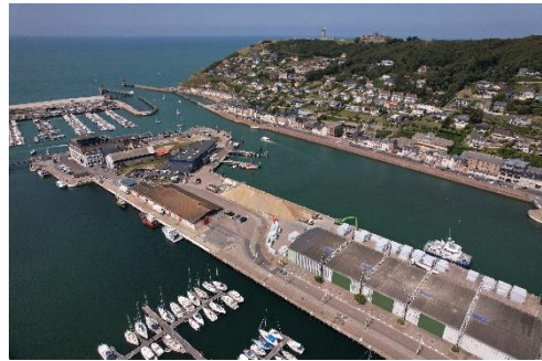
Vue aérienne du Port de Fécamp
