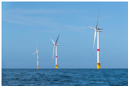
Parc éolien en mer de Fécamp ©Skyborn – Ulrich Wirrwa
