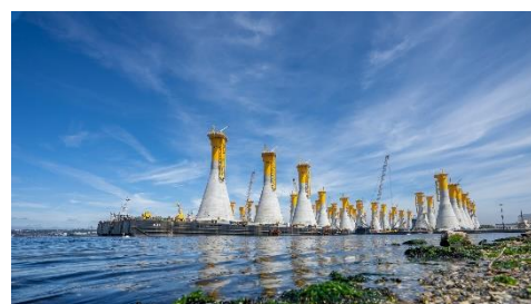
Usine de construction des fondations gravitaires du Parc éolien en mer de Fécamp ©Skyborn – Ulrich Wirrwa
