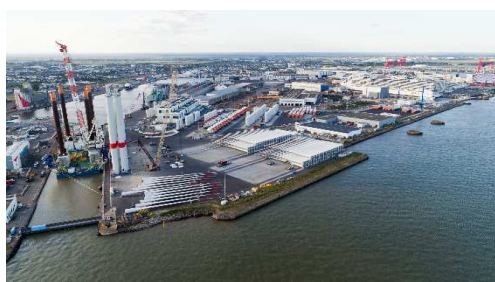
Site industriel et logistique de pré-assemblage des éléments d'éoliennes à Saint-Nazaire
