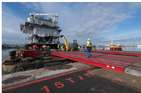
Chargement sur barge, à partir du quai de la Prise d'eau, d'une sous-station électrique construite par les Chantiers de l'Atlantique
