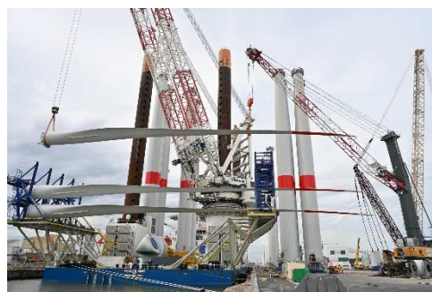
Lors du chargement des pales d'éoliennes sur le navire poseur, Le Vole au Vent, à Saint-Nazaire
