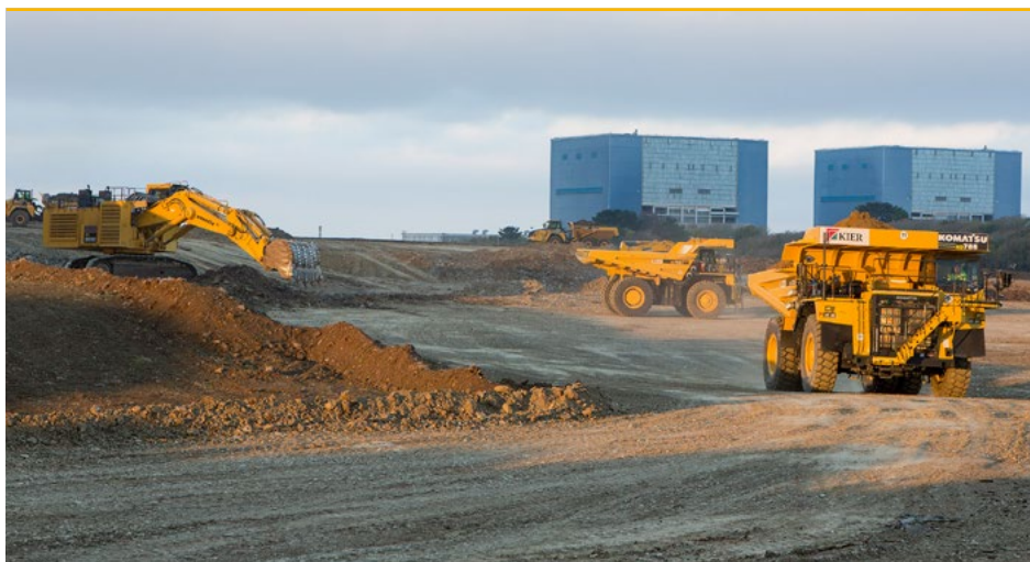
Les travaux préparatoires du site de Hinkley Point C en 2015 (projet EPR au Royaume-Uni)
