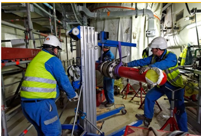
Montages mécaniques sur le chantier de l'EPR de Flamanville en 2014
