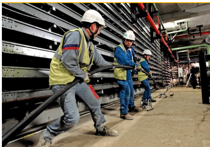
Montages électriques sur le chantier de l'EPR de Flamanville en 2014
