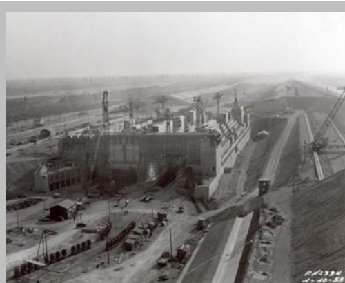
1955 : Le Rhin industriel, vue aérienne du chantier de construction de la centrale hydraulique de Fessenheim – Source : https://www.aufildurhin.com/
