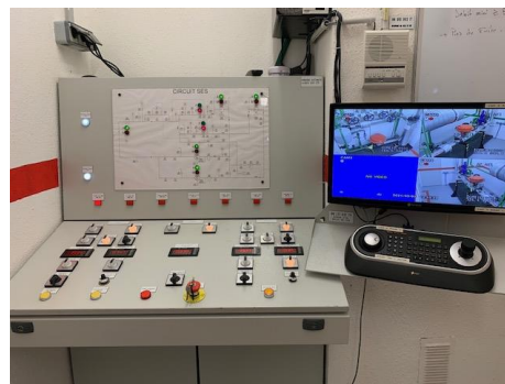
Chantier école scn-csq d'Obernai
