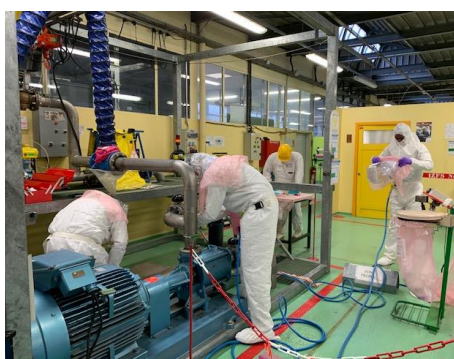
Chantier école scn-csq d'Obernai
