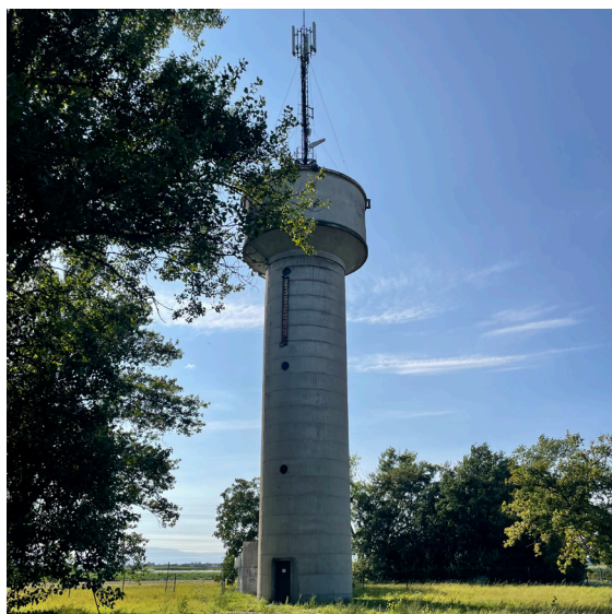
Château d'eau du site de Fessenheim.
