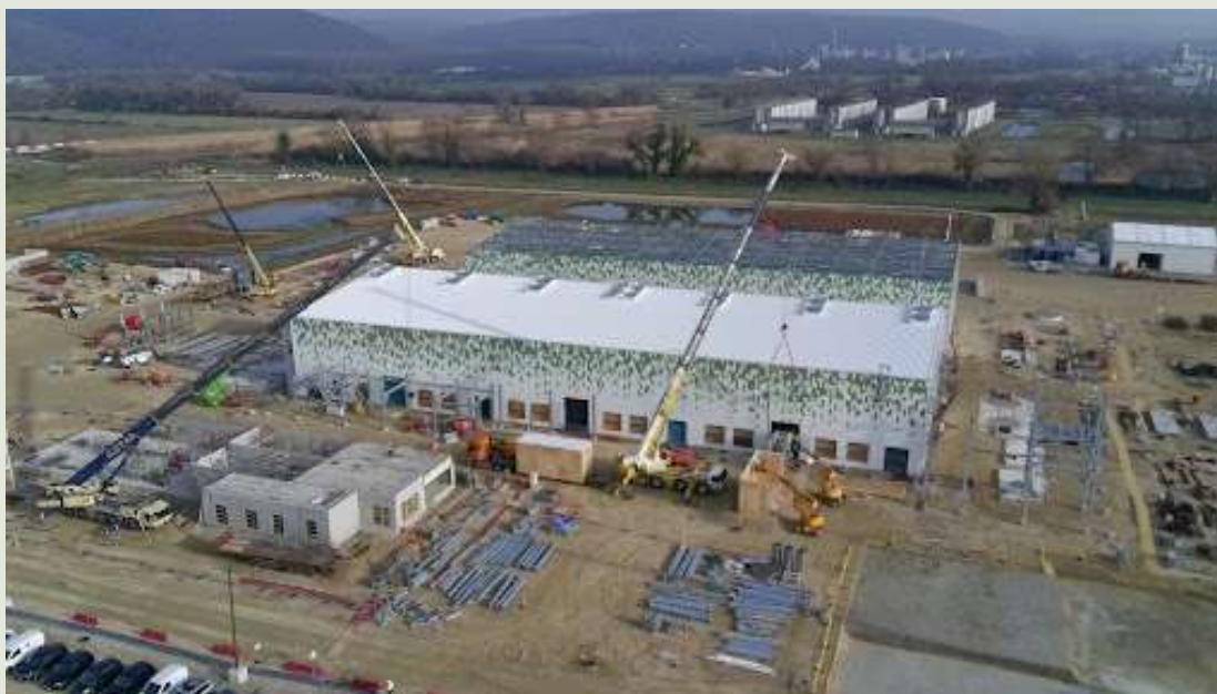
Figure 2 - Vue aérienne du chantier Normand'Hy (2025)
