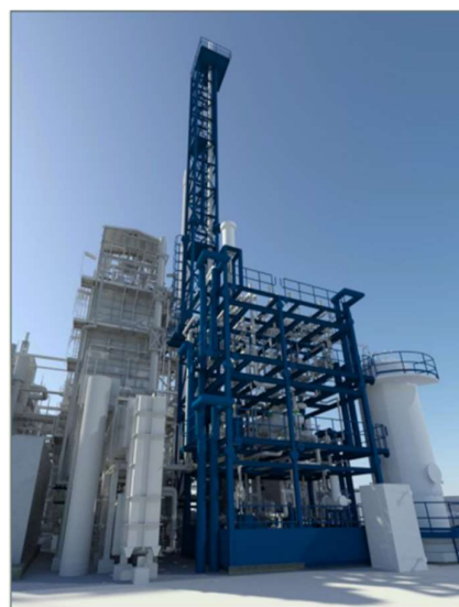
Figure 11 – La solution d'Air Liquide pour la production d'hydrogène par craquage d'ammoniac 17
