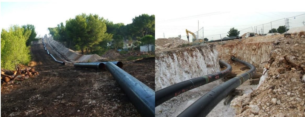
Exemples de canalisations NaTran, avant enfouissement
