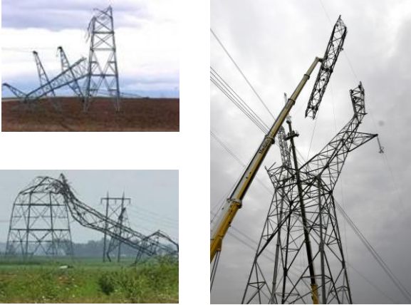
Sécurisation mécanique du réseau suite à la tempête de 1999
