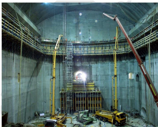
ATLAS, Caverne en travaux, point 1 du LHC. Crédit : CERN
