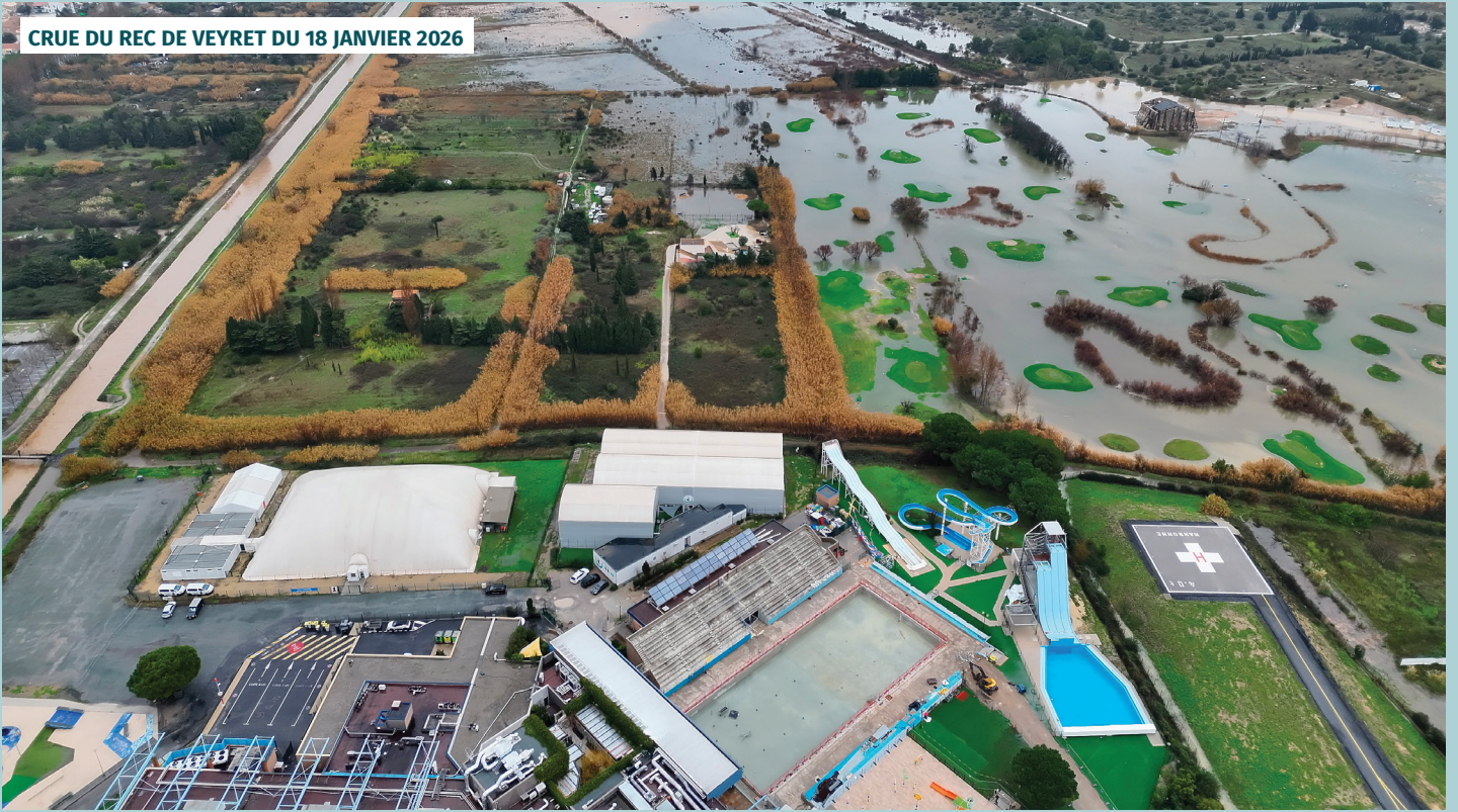
Inondation de la plaine en sortie de l'Espace de Liberté - Narbonne
