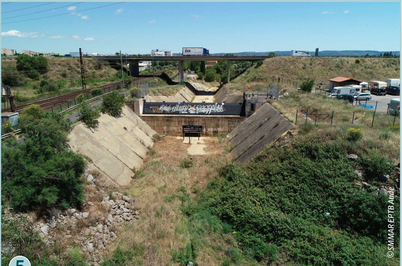
Ouvrage écrêteur de Cap de Pla
