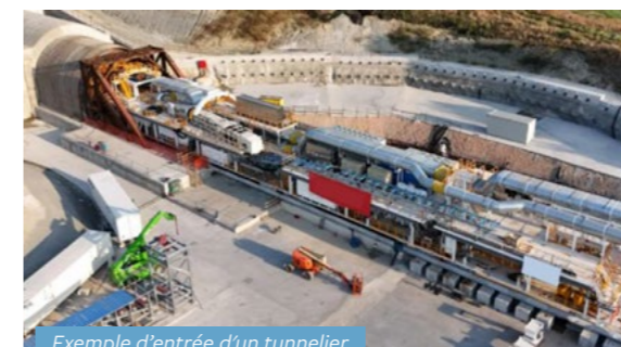
Exemple d'entrée d'un tunnelier
