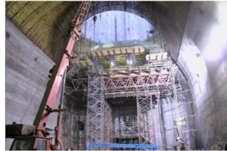
Construction de la caverne du CMS au CERN
