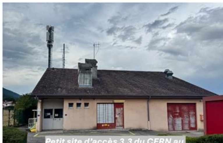
Petit site d'accès 3.3 du CERN au tunnel, Crozet Intégration paysagère zone urbaine
