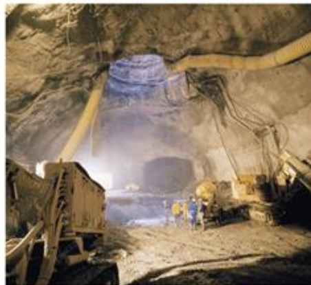
Une caverne du tunnel du LEP est excavée pour accueillir les équipements de l'une des expériences. 1983-1989. CERN CDS
