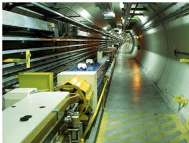
Le LEP - le plus grand accélérateur électron-positron - a été démantelé en 2000. Son tunnel de 27 kilomètres accueille maintenant le LHC – CDS CERN
