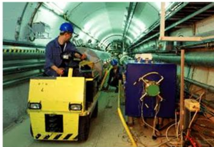
Démantèlement du LEP à mi parcours - mai 2001 - CDS CERN
