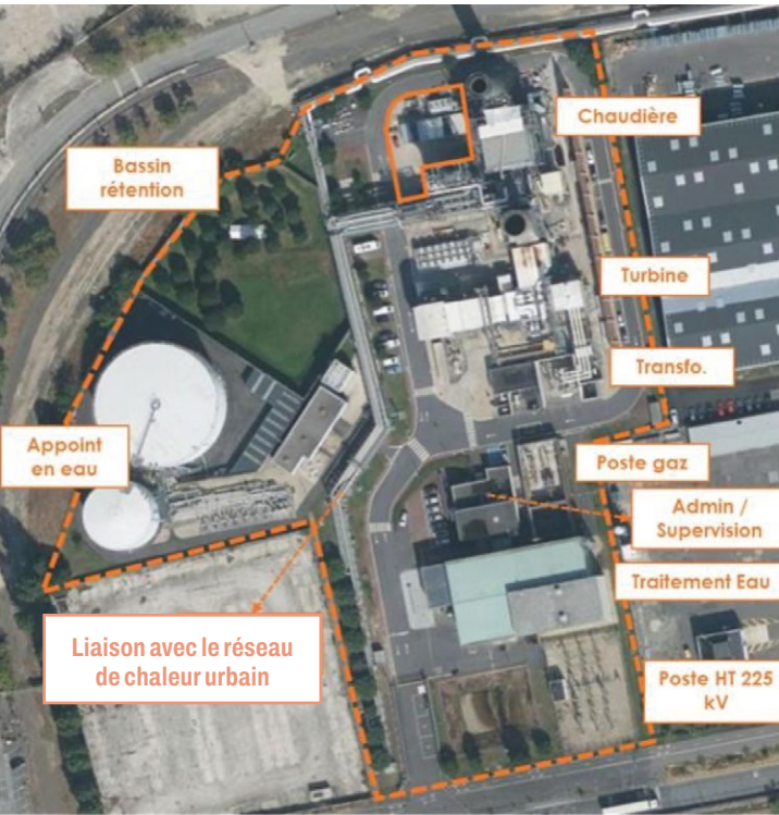
Les installations existantes de la centrale de cogénération de Vitry-sur-Seine
